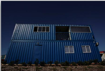
Бытовка Подсобное помещение для хранения вещей и отдыха рабочих
